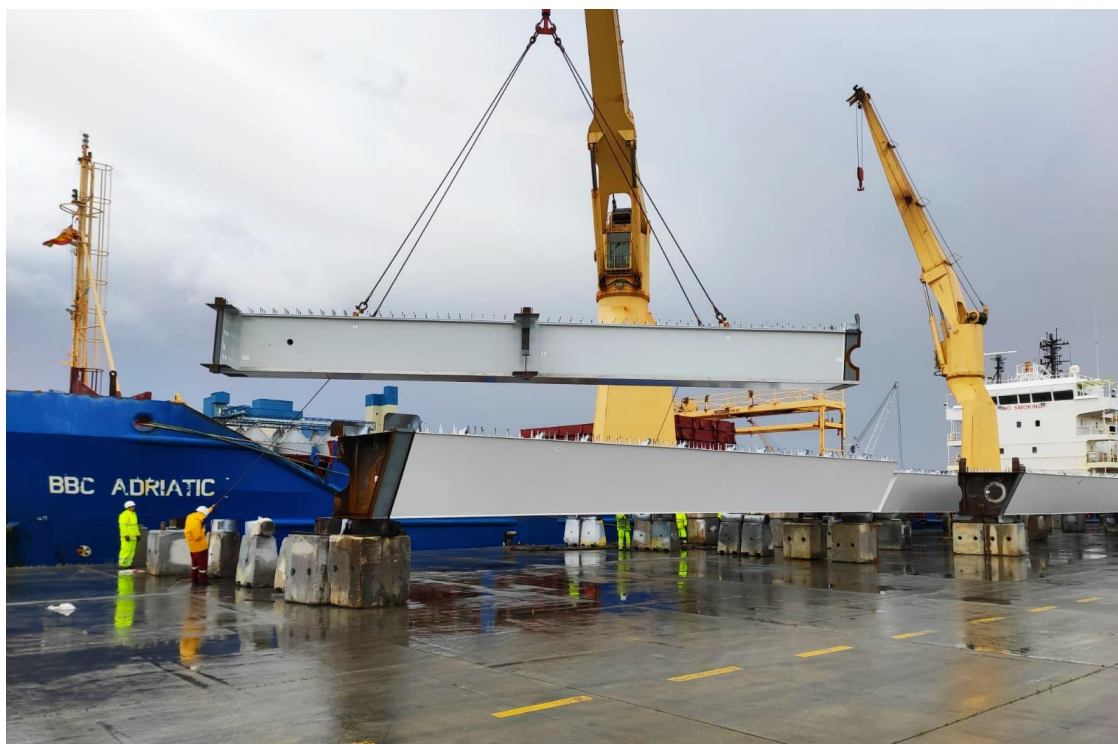
Carga de pieza TECADE para el puente de Hisingsbron.
