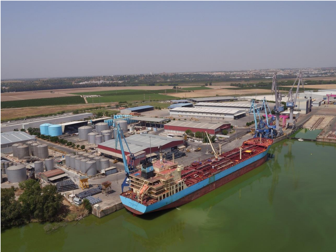
Instalaciones de Sevitrade en el Puerto de Sevilla
