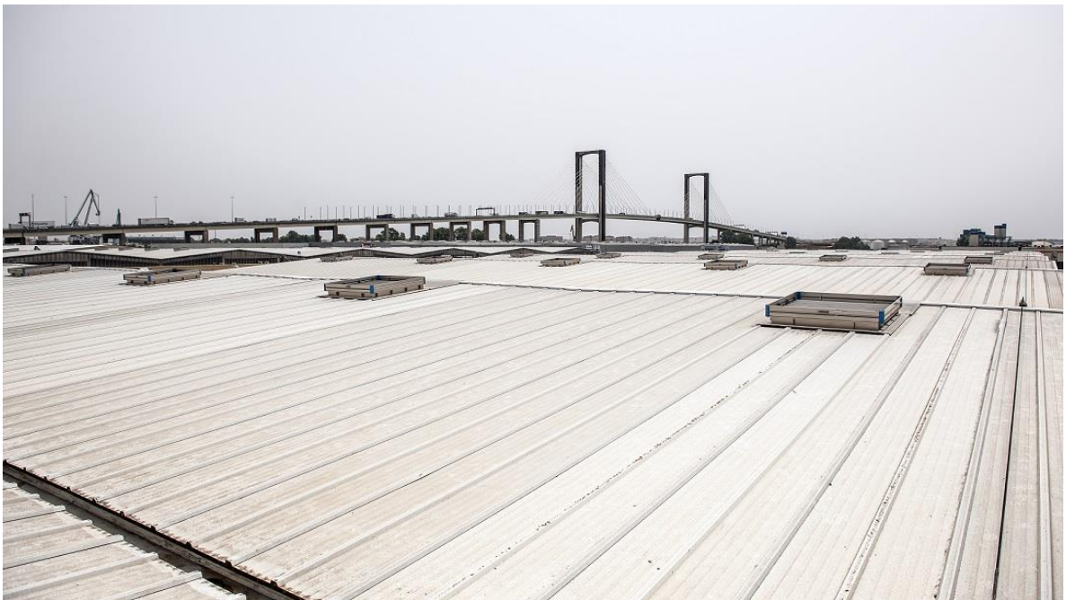
Cubiertas de las naves logísticas del Puerto de Sevilla
