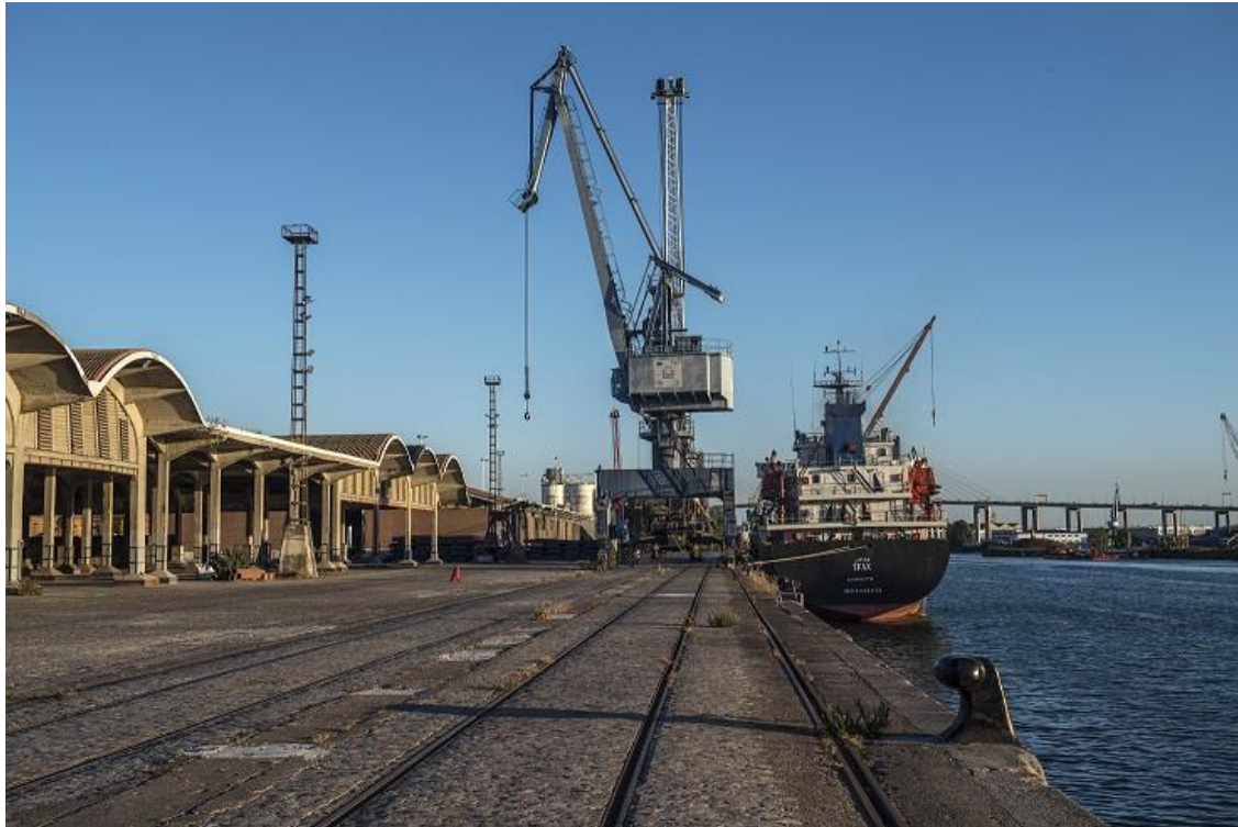
Actividad en el Muelle de Tablada que se trasladará hacia el sur.
